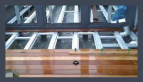
Rinnen und sonstige Sonderkonstruktionen anlegen bzw. montieren. Auflegen des Belages (Holz, Betonplatten oder andere).
