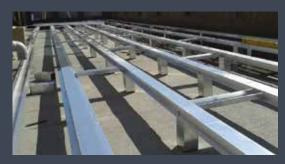
Vom Starterprofil ausgehend, fortlaufend aufstellen. Abstände der Trägerprofile und das Ausrichten der Höhenlagen mit dem Richtscheit laut Verlegeplan. Querträger mit Standardabstand befestigen und Trägerprofile wie Starterprofil im Achsraster gem. Verlegeplan auslegen.
